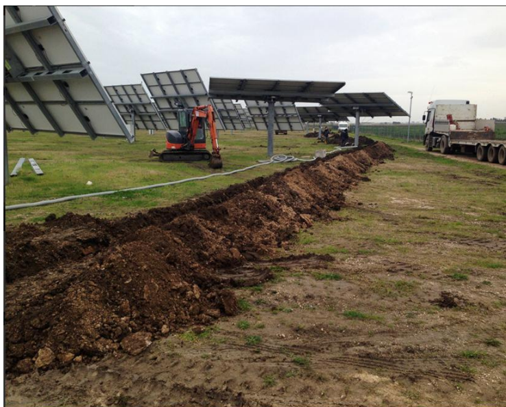
Figura 39: Esempio della fase di scavo trincee
