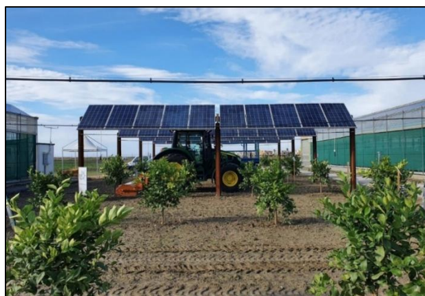
Figura 17: Esempio di integrazione agro – energetica di un impianto agrivoltaico
